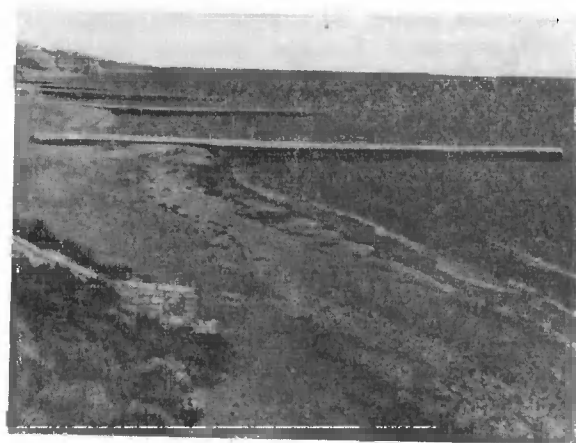
Укрепление берега бунами в районе пляжа «Отрада»
